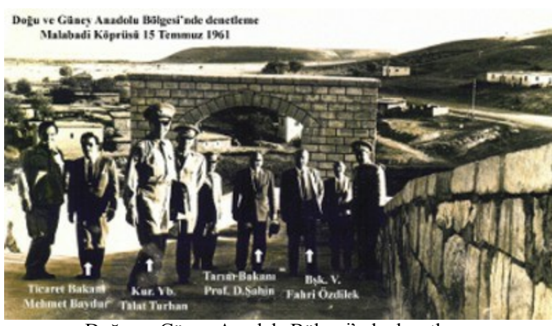
Doğu ve Güney Anadolu Bölgesi'nde denetleme
